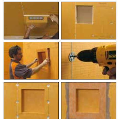
Einbau in KERDI-BOARD
