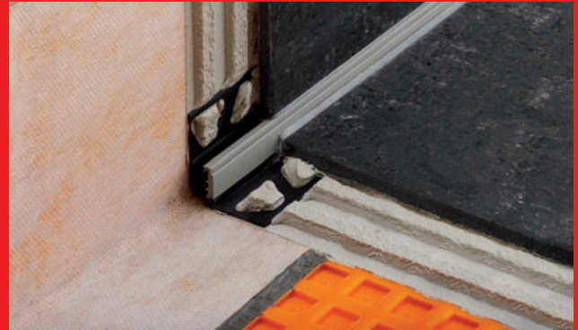
Sicherheit für die Fliesenkanten im Boden-Wand-Übergang bieten unter anderem die „Schlüter-Dilex-RF“-Profile.
