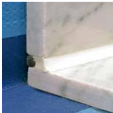
**Die Schaustücke zeigen eine hinterfüllte Dichtstoffuge im Anschluss vom Boden zur Decke ...**
