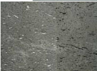
Üblicherweise werden zementäre Fugenmassen eingeschlämmt. Bei einigen Gesteinsarten oder rauen Oberflächen ist das aber nicht ohne Weiteres möglich: Links das Schadensbild an einer offenporigen Basaltlava nach dem Einschlämmen.
