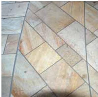
Der Unterschied zwischen den starren zementären Mörtelfugen und den Bewegungsfugen aus elastischer Dichtmasse ist deutlich erkennbar.
