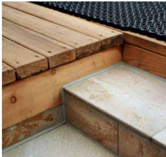
Zwischen unterschiedlichen Materialien vermittelt eine elastische Dichtmasse die Spannungen, die aufgrund thermischer und mechanischer Belastung entstehen.
