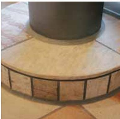
Aufgehende Bauteile werden mit einem elastischen Dichtstoff angeschlossen. Vor der Natursteinverlegung wurde eine Dichtschlämme zweifach vollflächig aufgetragen.
