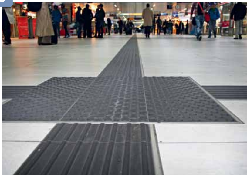
Der Verlegeplan stellte sicher, dass auch die Knotenpunkte der Leitbestreifung technisch wie optisch einwandfrei ausgebildet wurden.
