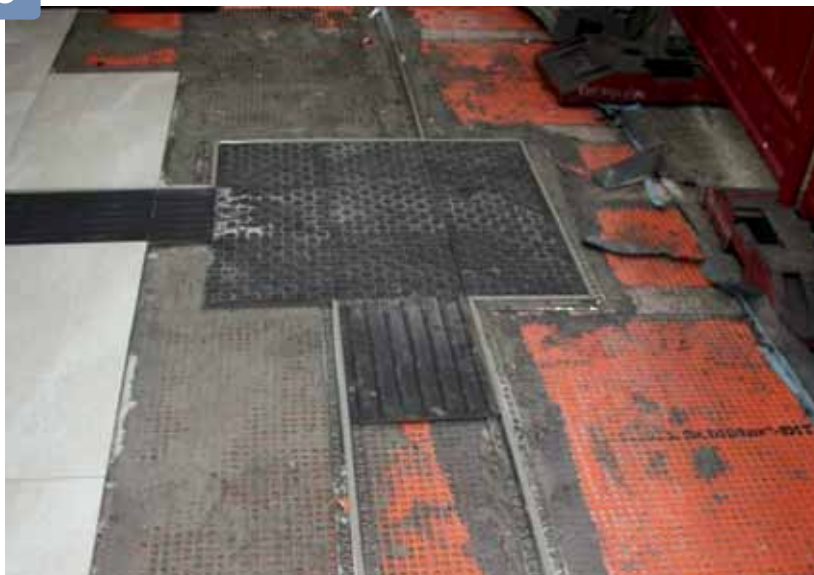
Zur optimalen Verkrallung wurden die quadratischen Vertiefungen in der Entkopplungsbahn ausgespachtelt.
