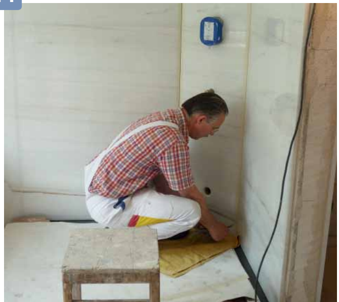
Die elastischen Anschlussfugen sind in den gleichen Farben ausgeführt wie die zementären Fugen.
