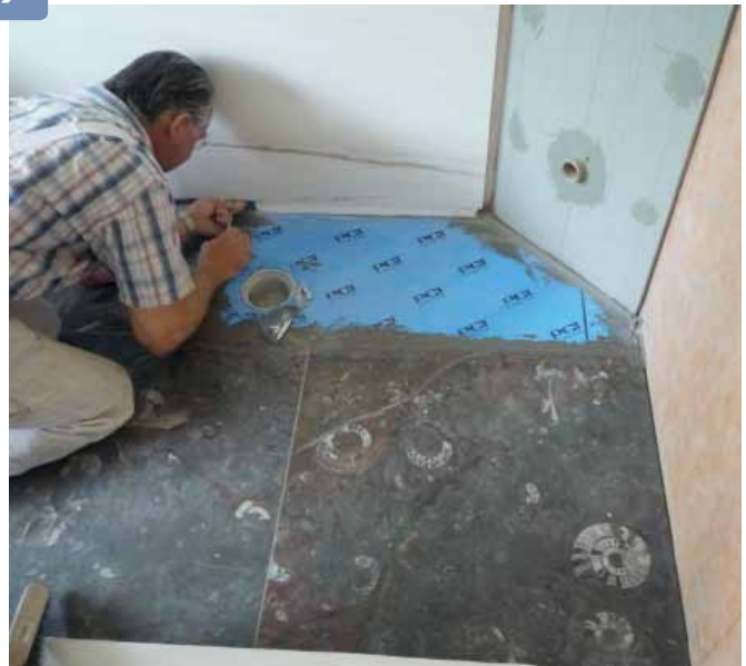
Eine selbstklebende Verbundabdichtung verhindert die Durchfeuchtung; auch im Wandbereich wurde eine Dichtungsbahn angebracht.
