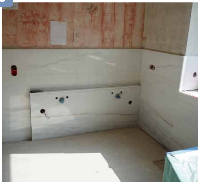
Die 2 cm starken Platten aus Göflaner Marmor wurden mit weißem Spezialmörtel im Buttering-Floating-Verfahren angesetzt.
