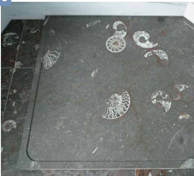
Aufgrund der Aufbauhöhe des Bodenablaufs liegt der Antritt 4 cm über dem Bodenniveau.
