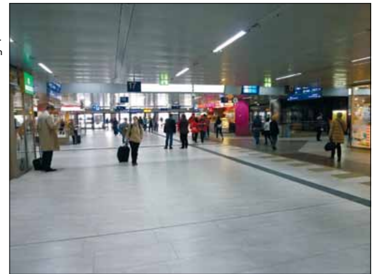
Um eine hohlraumfreie Verlegung zu gewährleisten, wurden die Fliesen im Buttering-Floating-Verfahren verlegt.
