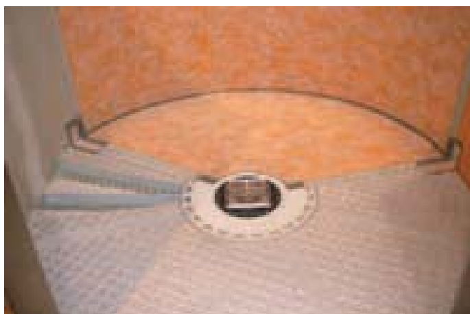
Abfluss: Mit Schlüter-Kerdi-Shower können wahlweise runde oder eckige Duschanlagen barrierefrei ausgeführt werden.
