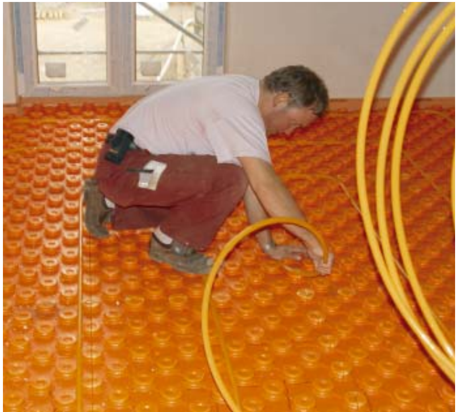
Das System „Schlüter-Bekotec-Therm“ basiert auf einer Polystyrol-Estrichnoppenplatte, die zugleich dämmende Eigenschaften besitzt. Zwischen den Noppen werden die Heizrohre geklemmt. Fotos (2): SSK-ARCHIV
