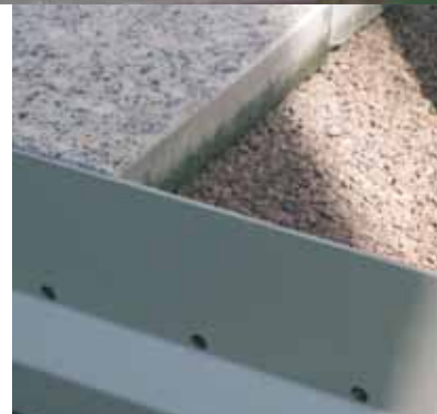
Speziell für Treppen und große Flächen im Außenbereich wurde die Verbunddrainage und -entkopplung Ditra-Drain 8 entwickelt. Fotos (3): SSKG-ARCHIV
