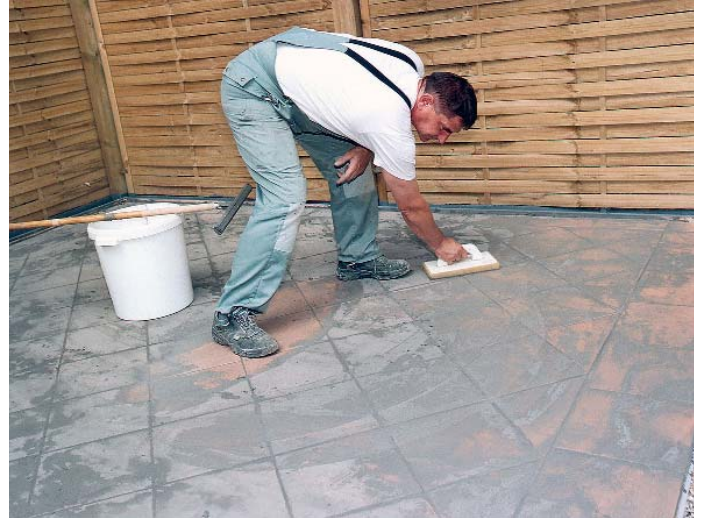
Nach dem Einschlämmen des flexiblen Fugenmörtels CE 37 von Ceresit mit dem Gummiwischer wurde das Material mithilfe eines Schwammbretts eingewaschen.
