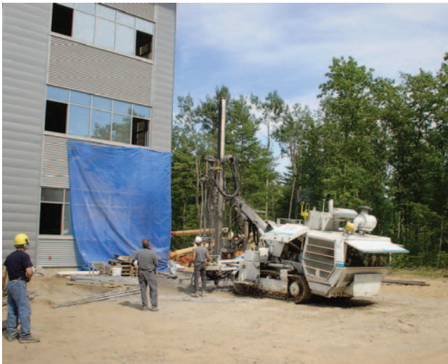
In 32 breiten Bohrlöchern, die rund 45 Meter tief in die Erde reichen, wurden die Kunststoffrohre zur Aufnahme der Erdwärme verlegt.
