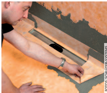
Die Abdichtung mit Kerdi ist Bestandteil des Systems.
