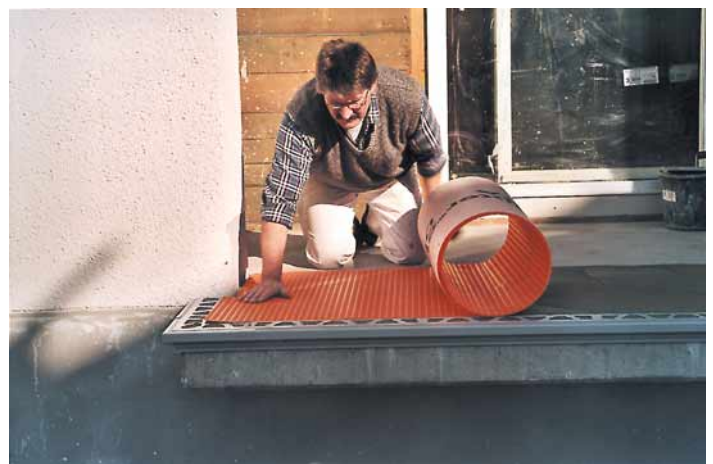
Die Entkopplungsmatte wird mit Fliesenkleber auf der Kragplatte verklebt.
