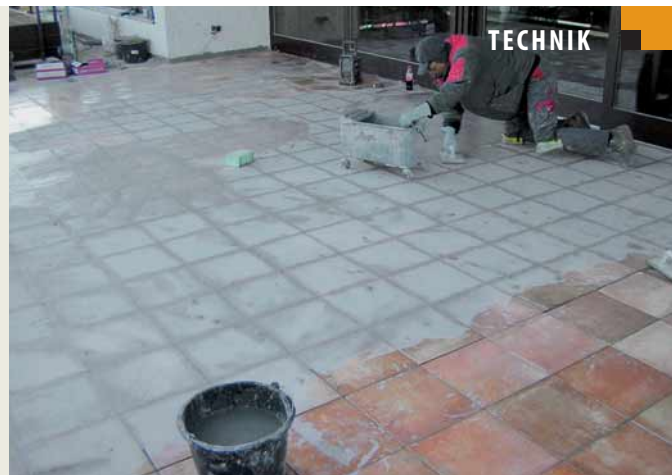
Verfugt wurde das glasierte Feinsteinzeug mit einem Trass-Naturstein-Fugenmörtel, der die rustikale Anmutung des Belags unterstützt. Die Belagsfelder wurden entsprechend des Fugenrasters angelegt, der Estrich hierfür nachträglich eingeschnitten.
