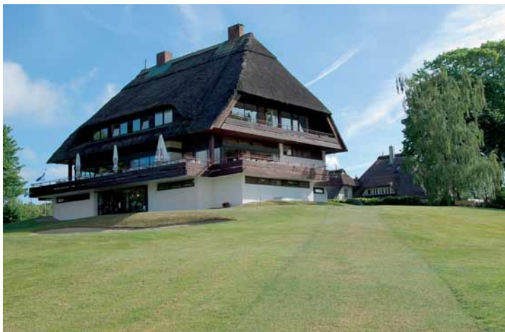
Die teils freikragende, teils unterwohnte Terrasse, die sich um das gesamte Haus herumzieht, wurde bei der Sanierung ab Betonsohle komplett neu aufgebaut.
