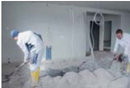
2. ThermoWhite® wird vor Ort gemischt und mittels Förderschlauch in das Haus befördert.
