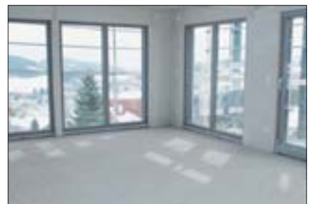
6. Wärmedämmung und Niveausgleich in einem Arbeitsgang.
