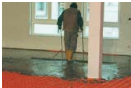
8. Einbau des Estrichmörtels ohne Bewehrung und ohne Bewegungsfugen. (Ausnahme: Bauwerksfugen / Bautrennfugen im tragenden Untergrund sind zu übernehmen.)
