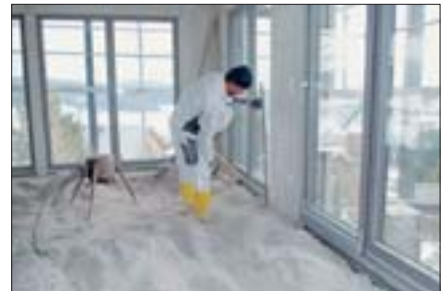
3. Die Wärmedämmung wird laut Waagriss auf das vorgesehene Niveau eingerichtet ...
