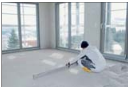
5. ... und ebenflächig verlegt.
