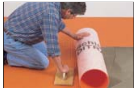
9. Vor der Verlegung von Keramik oder Naturstein: Einbau der Entkopplungsmatte Schlüter®-DITRA 25 direkt nach Begehbarkeit des Estrichs. Bei Calciumsulfatestrich ab einer Restfeuchte von \leq 2\% .
