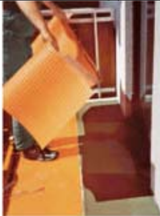
4 Bahnen stumpf aneinander legen. Letzte Matte reicht bis ganz an die Wand. Mit Cuttermesser schneiden.
