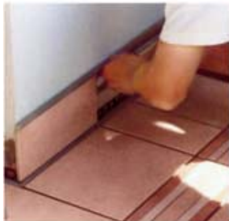
10 Unteres Abschlussprofil aufkleben. Sockelfliese als Maß für das obere Profil: Anzeichnen, kleben.
