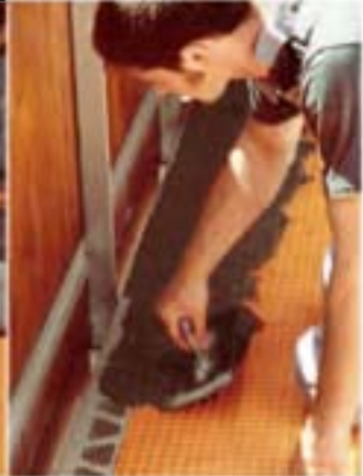
6 Kleber aufs Winkelprofil geben, ebenen. Drauf achten, das Balkon-Gefälle von 1,5 bis 2 % zu erhalten.
