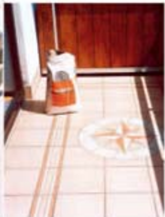
13 Verfugen: Masse anrühren, mit Gummirakel fest in die Fugen reiben. Etwas trocknen lassen, dann reinigen.
