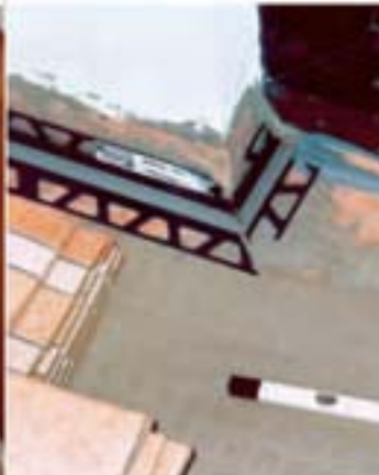
8 Nahtstelle zur Wand überbrücken: Eckprofil auf Gehung schneiden und mit Dünnbettmörtel fixieren.
