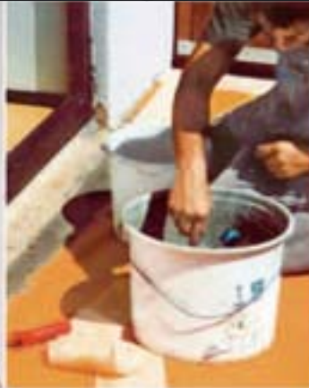
5 Dünnbettkleber anrühren, um Profile und Nahtstellen an Mattenstößen und zur Wand abzudichten.
