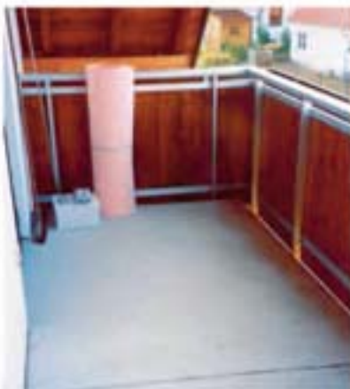
1 Oberfläche säubern, lose Teile entfernen. Dellen mit Spachtelmasse ausgleichen und trocknen lassen.
