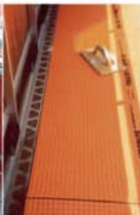
2 Dünnbettkleber am Rand aufkämmen, Winkelprofil einbetten. Orangefarbige Matte zuschneiden.
