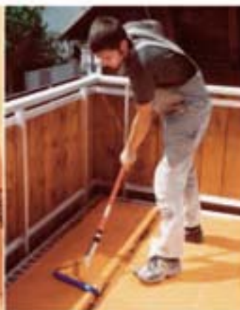
3 Kleber flächig auftragen, wieder 4 mm dick. Matten auslegen, fixieren mit Roller oder mit Reibebrett.
