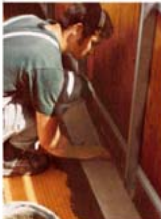
7 Abdichtband 18,5 cm breit einlegen und gut festklopfen. 12,5 cm breites Band für Mattenstöße nehmen.
