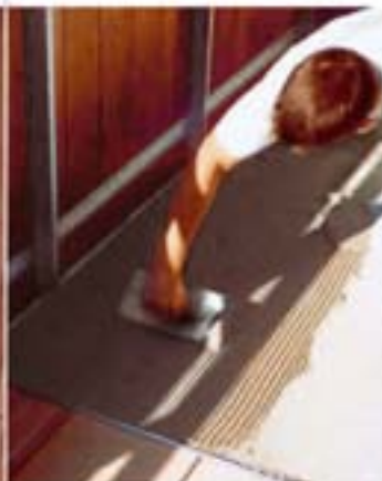
12 Fliesenbeläge über 2,5 Meter Länge durch Schienenprofile unterbrechen: einfach in die Fuge einkleben.
