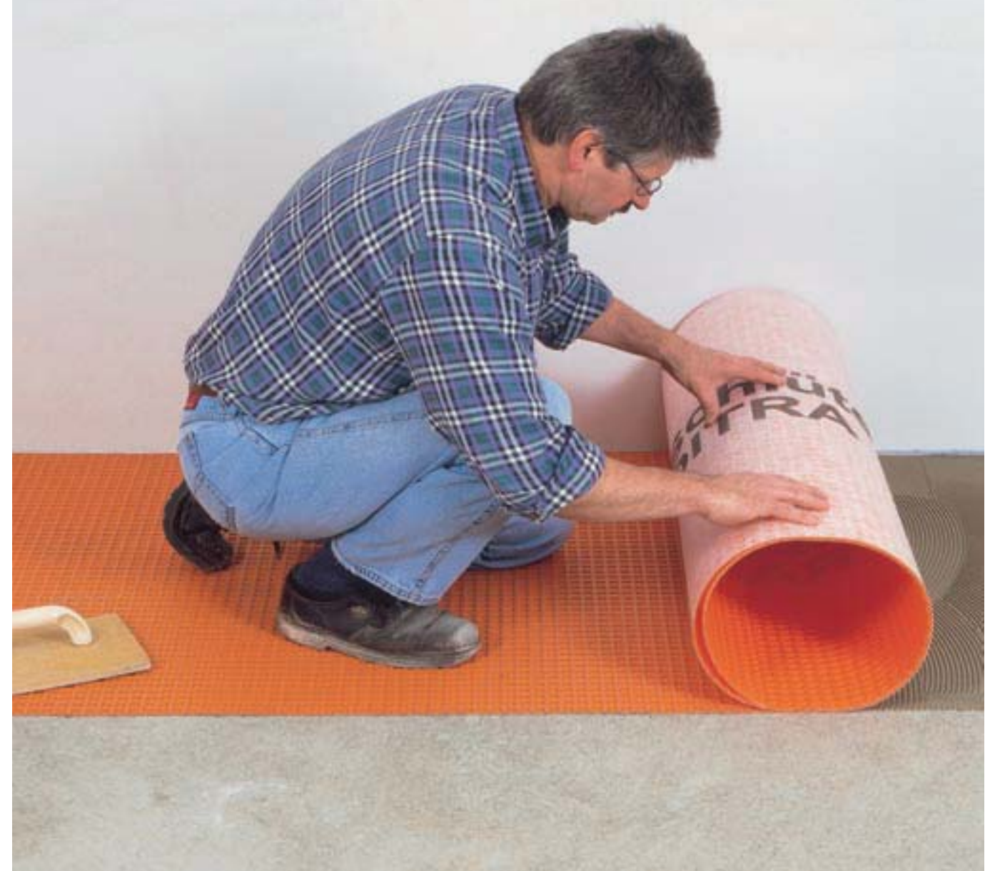
Auf neuen Unterlagsböden kann die DITRA-Matte unmittelbar verklebt werden, sobald sie begehbar sind. Um die volle Funktionstüchtigkeit zu erhalten, wird die Matte mit der Vliesseite vollflächig in das Kleberbett eingedrückt, so dass ein optimaler Haftverbund zum Untergrund entsteht.
