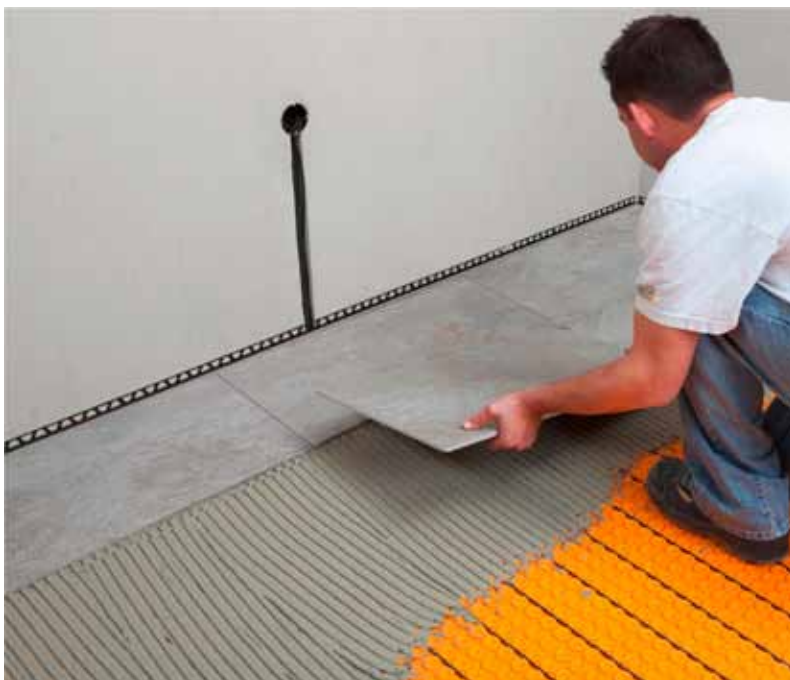
Verlegung der Bodenplatten
