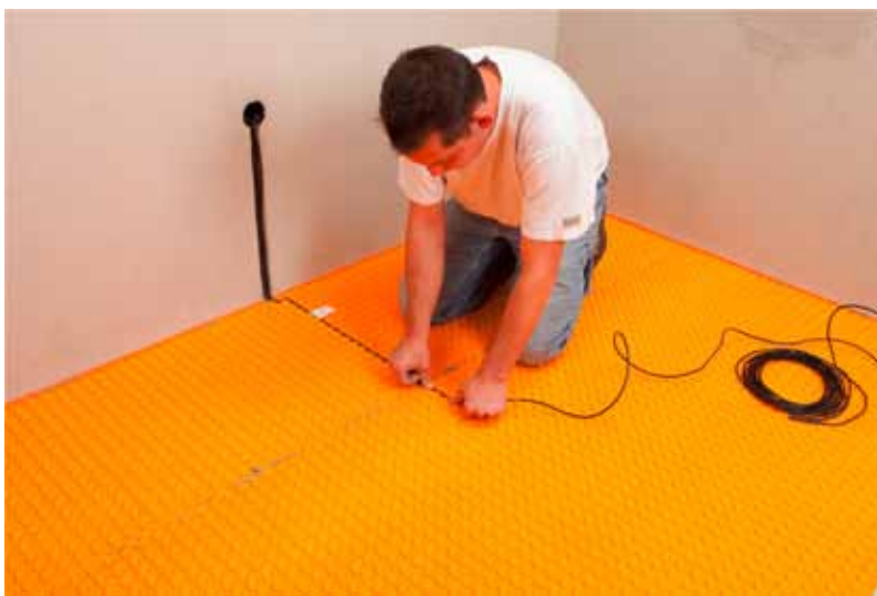
Einbau der Heizkabel
