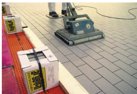
Der Haftverbund der Fliesen wird durch die Rütteltechnik optimiert, mit der ein hohlraumfreies Mörtelbett erzeugt wird. | Fotos: Schlüter Systems
