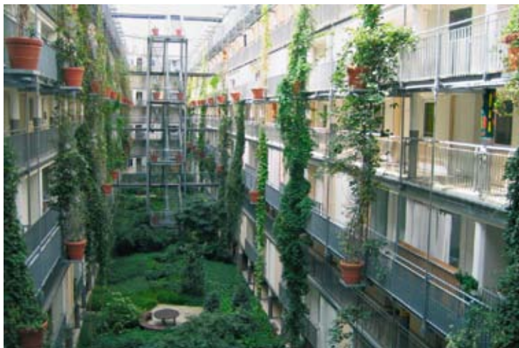
Die Konstruktionsaufbauten für Balkone haben sich bei vielen Renovierungen und Neubauten bewährt – hier die Beispiele von Mehrfamilienhäusern in Leipzig und Rastatt
