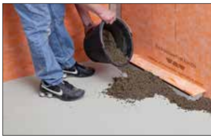
11 Gefälleestrich (2%) der Duschkfläche aufbringen.
