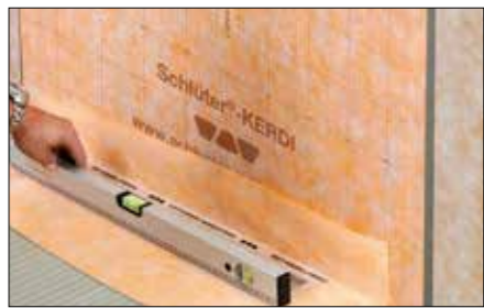
10 Rinnenkörper mit Wasserwaage ausrichten.
