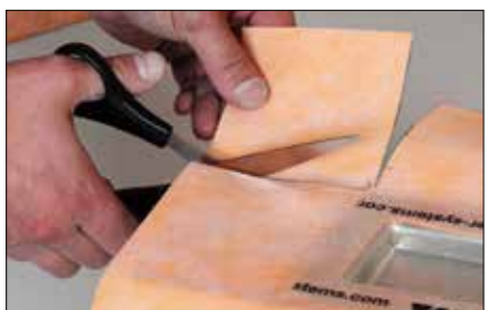
1 Schlüter®-KERDI Manschette für den Eckbereich zuschneiden.
