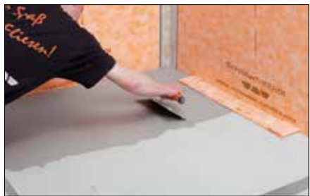
12 Die Erstrichfläche mit Dünnbettmörtel versehen. Die Zahnungsempfehlung bei der Verwendung von DITRA 25 ist 3 x 3 oder 4 x 4 mm. Bei der Verwendung von DITRA-HEAT, 6 x 6 mm.
