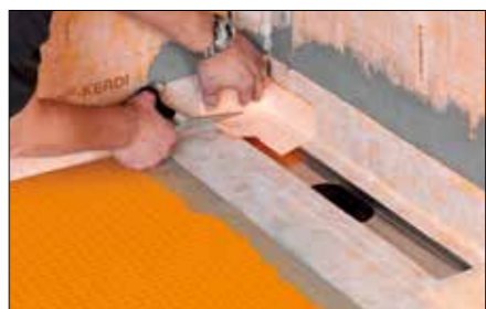
II Schlüter®-KERDI Manschette mit Schlüter®-KERDI-COLL-L dicht verkleben. Die im Lieferumfang enthaltene Schlüter®-KERECK Innenecke zuschneiden ...
