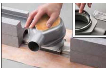
7 Ablaufgehäuse auf den Adapter setzen und eindrücken (mitgeliefertes Gleitfett verwenden).
