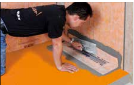
14 Schlüter®-KERDI Manschette mit Schlüter®-KERDI-COLL-L verkleben. Wand- und Bodenanschlüsse sind mit Schlüter®-KERDI-KEBA ebenfalls mit Schlüter®-KERDI-COLL-L dicht zu verkleben.
