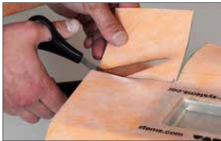
1 Schlüter®-KERDI Manschette für den Eckbereich zuschneiden.
