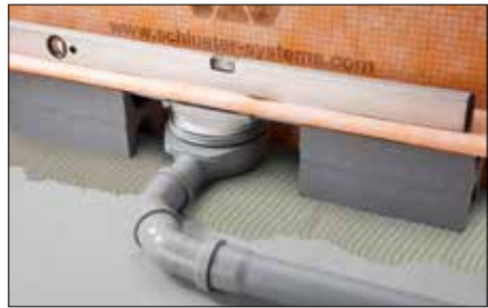
10 Rinnenkörper mit Wasserwaage ausrichten und Dichtheitsprüfung vornehmen.
