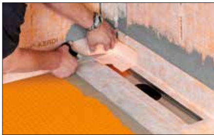
11 Schlüter®-KERDI Manschette mit Schlüter®-KERDI-COLL-L dicht verkleben. Die im Lieferumfang enthaltene Schlüter®-KERECK Innenecke zuschneiden ...
