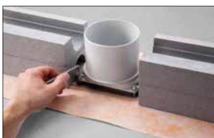
4 Zum Erreichen der minimalen Aufbauhöhe von 120 mm ist der Adapter zu kürzen. Hierzu Adapter mittels des beigefügten Imbusschlüssels vom Rinnenkörper lösen, abnehmen ...
