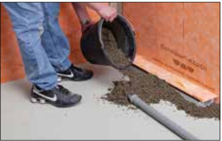
11 Gefälleestrich (2 %) der Duschfläche - ggf. auf geeignete Unterdämmung - aufbringen.
