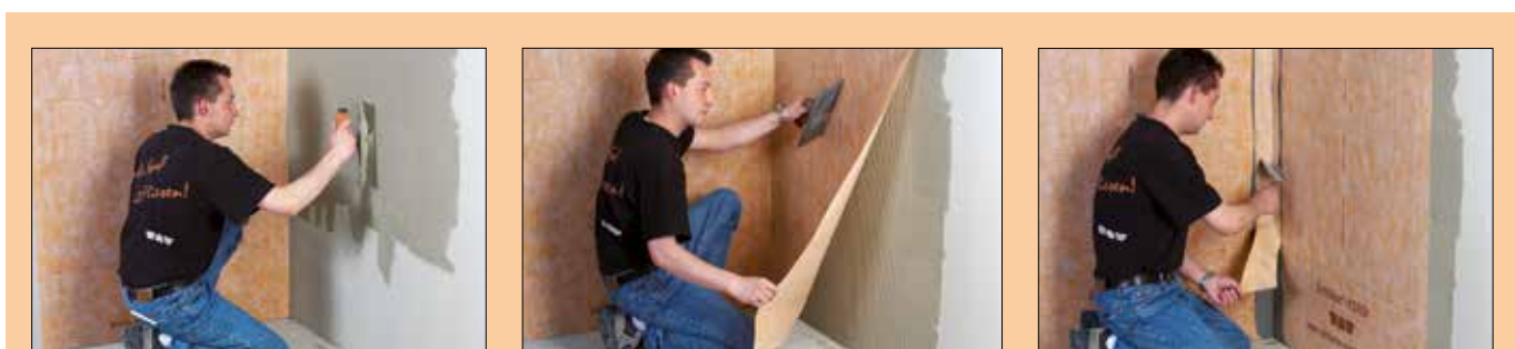
1 Dünnbettmörtel (Zahnung 3 x 3 mm) zur Verklebung der Verbundabdichtung Schlüter®-KERDI aufbringen. 2 Schlüter®-KERDI Bahn aufbringen und glätten. 3 Im Stoßbereich mit Schlüter®-KERDI-KEBA Band unter Verwendung von Schlüter®-KERDI-COLL-L vollflächig überkleben.
