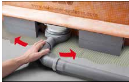
9 Ablaufrohr (bauseits) anbringen und ausrichten.
