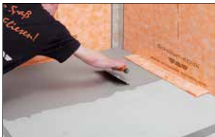
12 Die Estrichfläche mit Dünnbettmörtel versehen. Die Zahnungsempfehlung bei der Verwendung von DITRA 25 ist 3 x 3 oder 4 x 4 mm. Bei der Verwendung von DITRA-HEAT, 6 x 6 mm.
