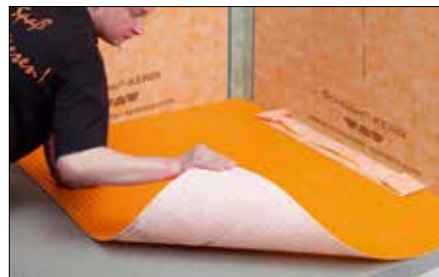
13 Schlüter®-DITRA-25 bzw. DITRA-HEAT aufkleben - Stöße sind mit Schlüter®-KERDI-KEBA unter Verwendung von Schlüter®-KERDI-COLL-L abzdichten (siehe Produktdatenblatt 6.1 bzw. 6.4).
