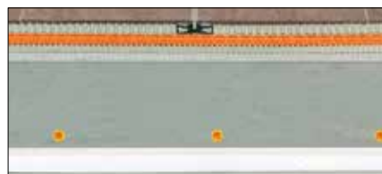
Aufbau nach DIN 18 560-2
