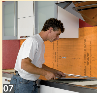
03 Einen geeigneten Verlegeuntergrund für den Wandspiegel erhält man durch das Verkleben einer dünnen Platte an der Wand.
