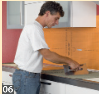
02 Ausschnitte kann man per Messer entlang dem aufgedruckten Schneidraster der beschichteten Hartschaumplatte schneiden.
