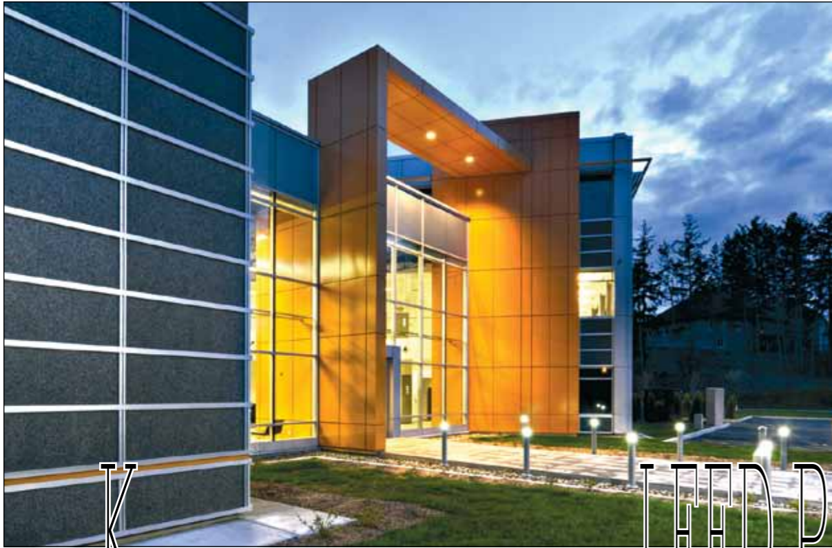
Das neue Verwaltungsgebäude von Schlüter-Systems Canada kombiniert anspruchsvolle Architektur und ökologisches Bauen
