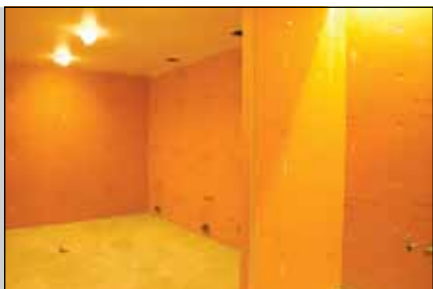
In den Sanitärräumen wurde mit der Bauplatte Kerdi-Board ein sauberer Verlegeuntergrund für den Fliesenbelag geschaffen. Und auch das Wasserbecken im Foyer wurde damit gebaut
