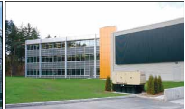
Die Glasfront des Eingangsbereiches wird von einer markanten Fassadenkonstruktion in der Hausfarbe des Unternehmens dominiert. Eine Solarwand an der Südfassade wird zum Vorheizen der Außenluft genutzt (rechtes Bild)
