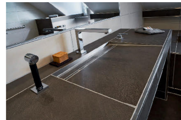
So wie die Dusche ist auch das Waschbecken mit einem linearen Ablauf versehen, der via Belagträger keramisch bekleidet ist und dadurch besonders edel und homogen wirkt.
