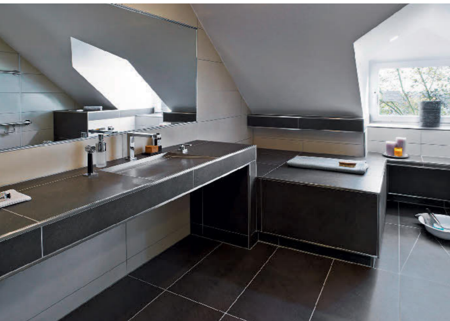
Komfort für alle Lebenslagen durch großzügige Verkehrsflächen ohne Schwellen, einen eleganten Waschtisch, der mit dem Rollstuhl unterfahrbar ist, sowie eine temperierbare Sitz- bzw. Liegefläche.
