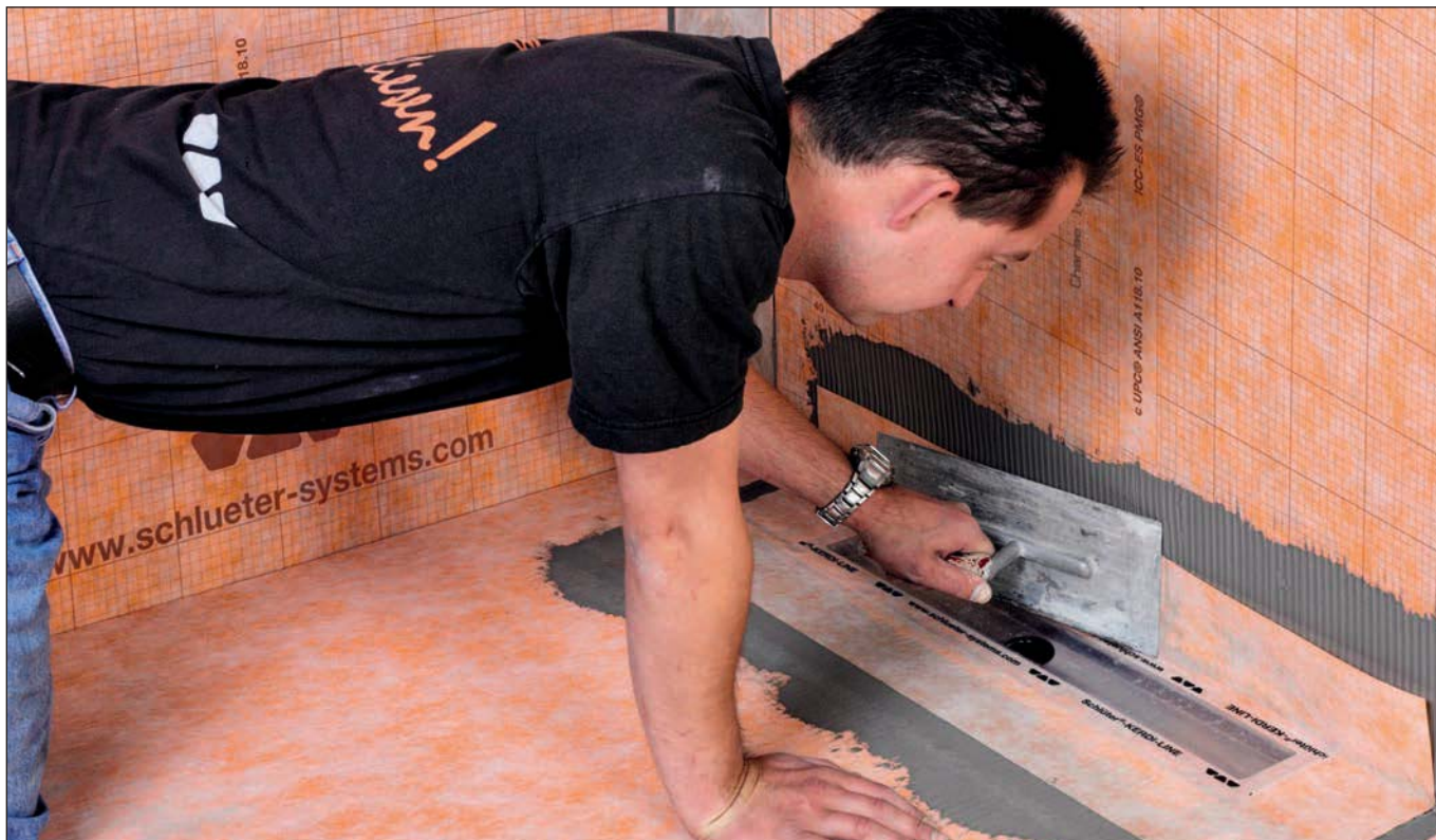
Die werkseitig angebrachte Dichtmanschette der Entwässerungsrinne wird an die Verbundabdichtung angeschlossen. Hier übernimmt der Hersteller des Ablaufsystems komplett die Gewährleistung für die Andichtung an den Rinnenkörper.
