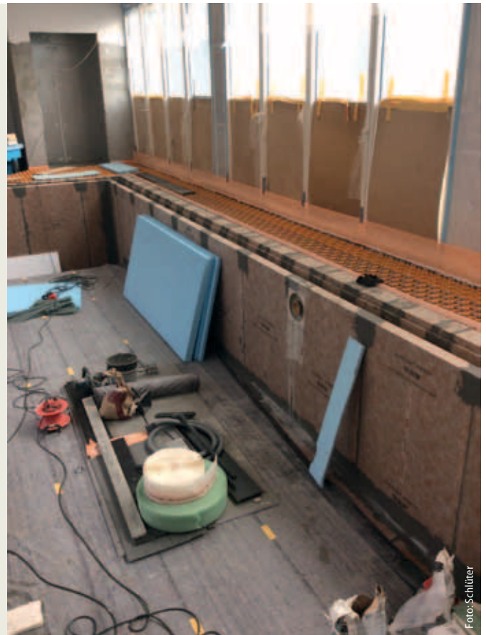
Abdichtungsarbeiten am Becken
