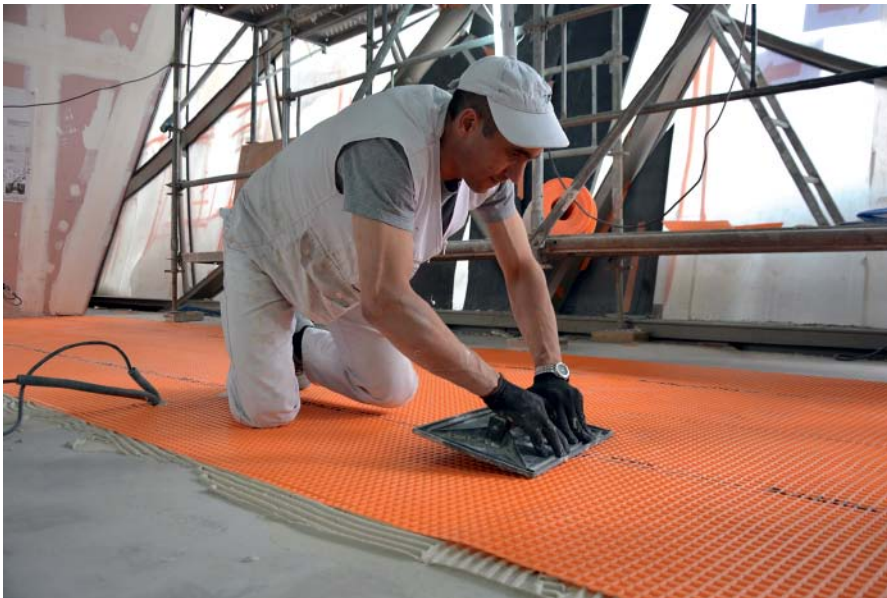
Die Verbundentkopplung wurde im Eiffelturm auf rund 300 Quadratmetern Bodenfläche verklebt, um die Bewegungen der unterschiedlichen Materialien sowie des Gebäudes zu neutralisieren.
