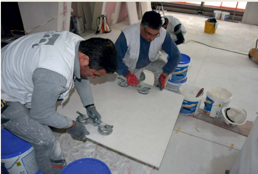
Auf der Entkopplungsmatte wurden die einen Quadratmeter großen Platten verlegt.
