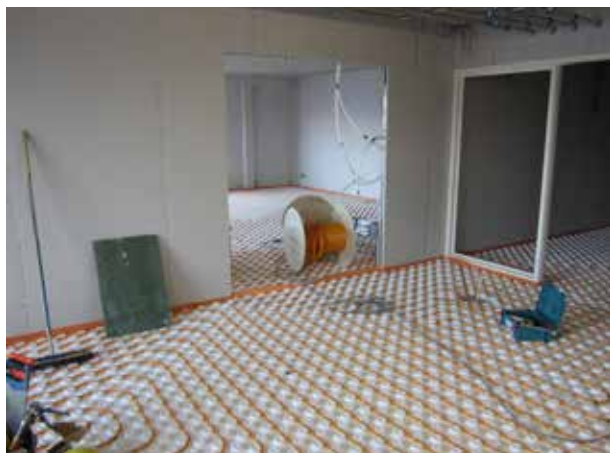
Bejaardenhuizen van vloer tot plafond individueel aangepakt
