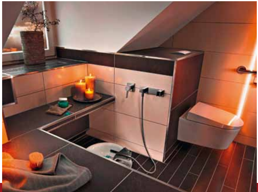
Unmittelbar neben der Sitzfläche der Wellnesszone befindet sich eine Handbrause inklusive Bodenablauf. (Fotos: GGT)
