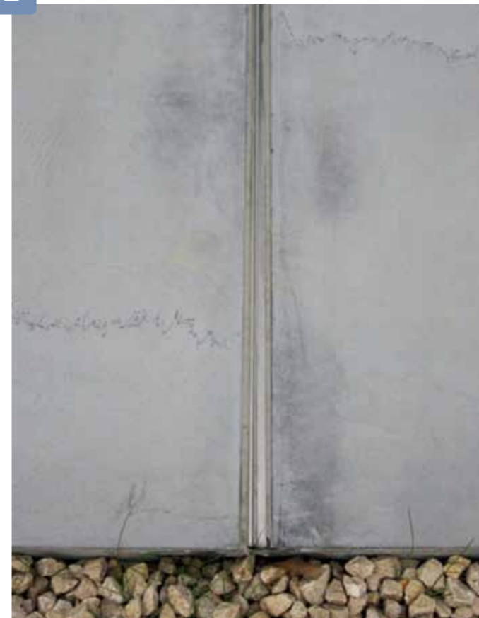
Nur 12 mm breit ist das Bewegungsfugenprofil. Die Nut- und Feder- bindung im Inneren fängt horizontale Bewegungen auf.
