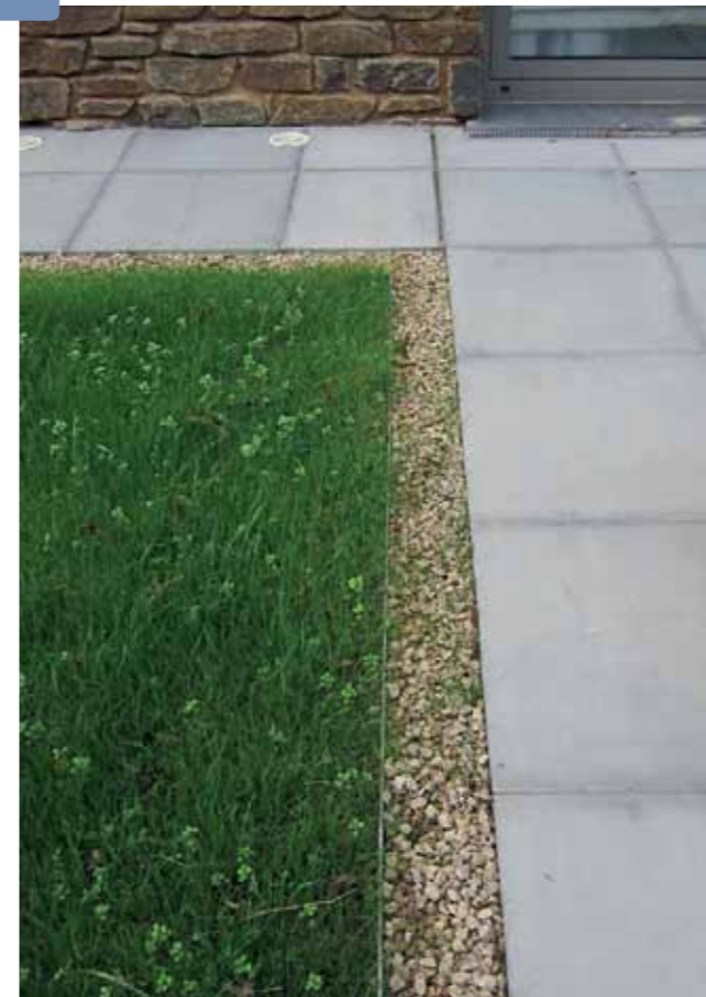
In den Randbereichen sorgen eigens angeordnete Drainagezonen dafür, dass das Regenwasser schnell abgeführt wird.
