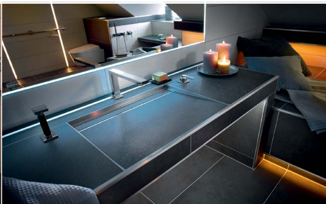
Im GGT-Bad gibt es eine weitere Variante der Linienentwässerung: Das Waschbecken wurde mit einem linearen Ablauf mit Belagträger ausgestattet, der den Fliesenbelag aufnimmt.
