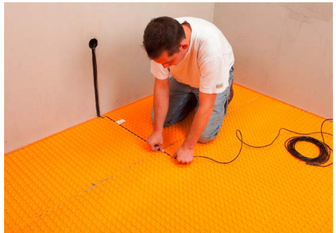
Der Verlegeabstand der Heizkabel beträgt 9 cm (jede dritte Noppe).
