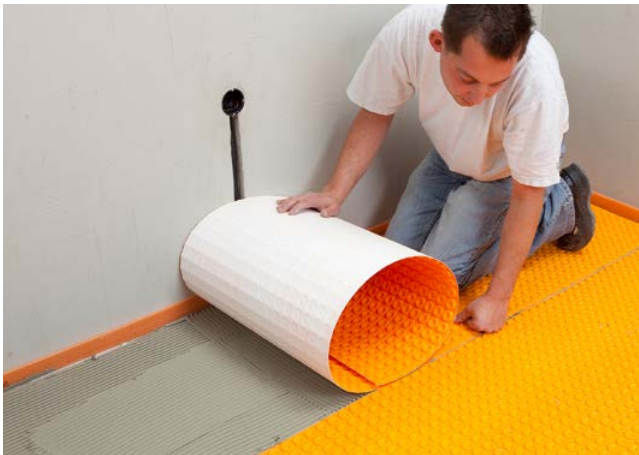
Verlegung der Entkopplungsmatte des Ditra-Heat-E-Systems.
