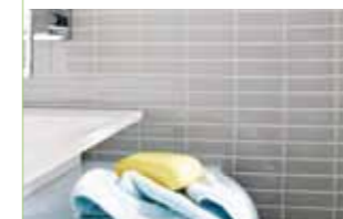
Keramikmosaik Während die Wände der Gästetoilette überwiegend verputzt wurden, hat man den Bereich hinter dem WC-Becken und dem Waschtisch mit dem elegant grau glänzenden Keramikmosaik „ST 330“ verfliesen. Die Fliesen setzen einen schönen Akzent.
