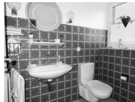
Die Gästetoilette aus dem letzten Jahrhundert war nicht nur der Optik wegen sanierungsbedürftig. Auch technisch musste einiges grundlegend verbessert werden.
