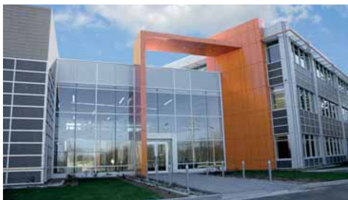
Der Energieverbrauch des Verwaltungsneubaus der Schlüter-Systems inc. Canada liegt rund 65 Prozent unterhalb dessen, was der „Code modèle national de l'énergie“ für Gebäude vorsieht. Das war LEED-Gold wert.
