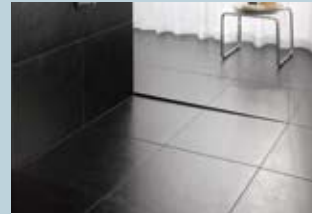
Duschrinne als optische Schwelle zwischen Walk-In-Duschbereich und weiterem Fliesenboden. (Linearis Super 60 von Kessel)
