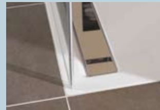
So rund wie die Dusche von Glamü: Die Glasflächen sind in den seitlichen Nuten der bodengleichen Duschrinne eingestellt. (Shower-Drain von Aco)
